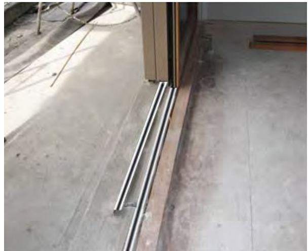
Relleno de la base de concreto
