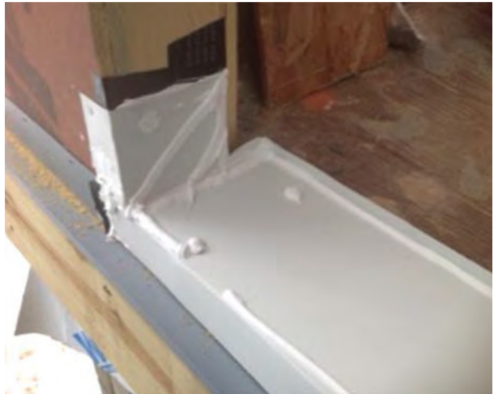
Instalación de bandeja de umbral rígida
