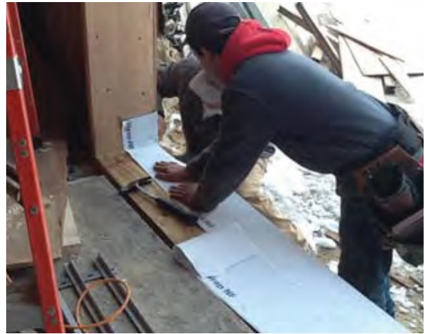
Instalación de bandeja de umbral flexible
