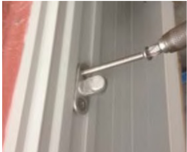
Instalación final del hardware
