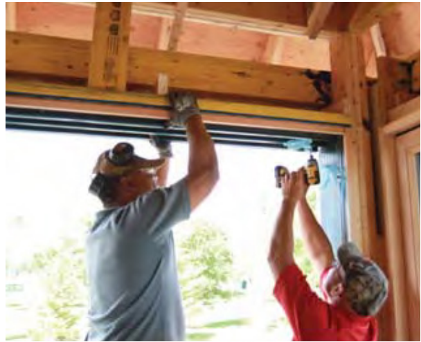
Instalación del riel superior
