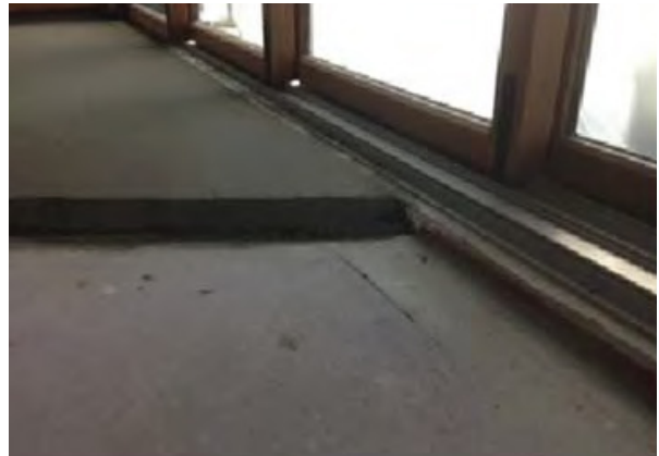
Relleno de la base de concreto
